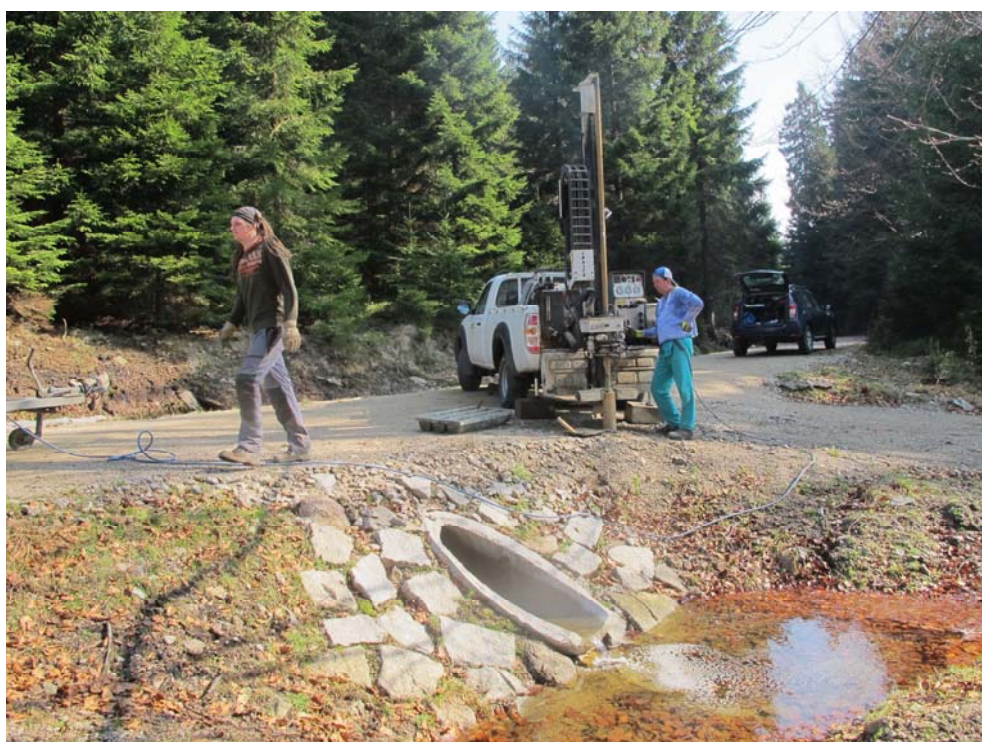
Obr. 2. Provádění vrtu J6.
